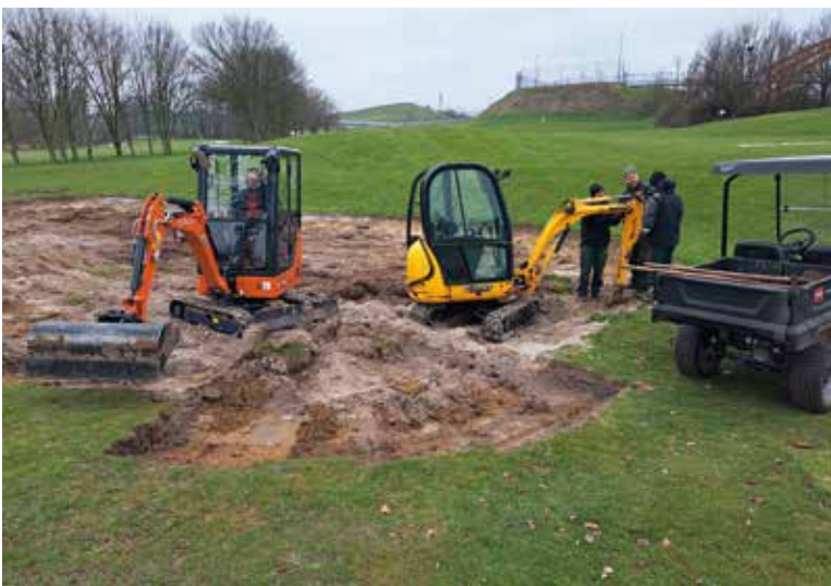
Het weghalen van de bunkers rechts van hole 6.
